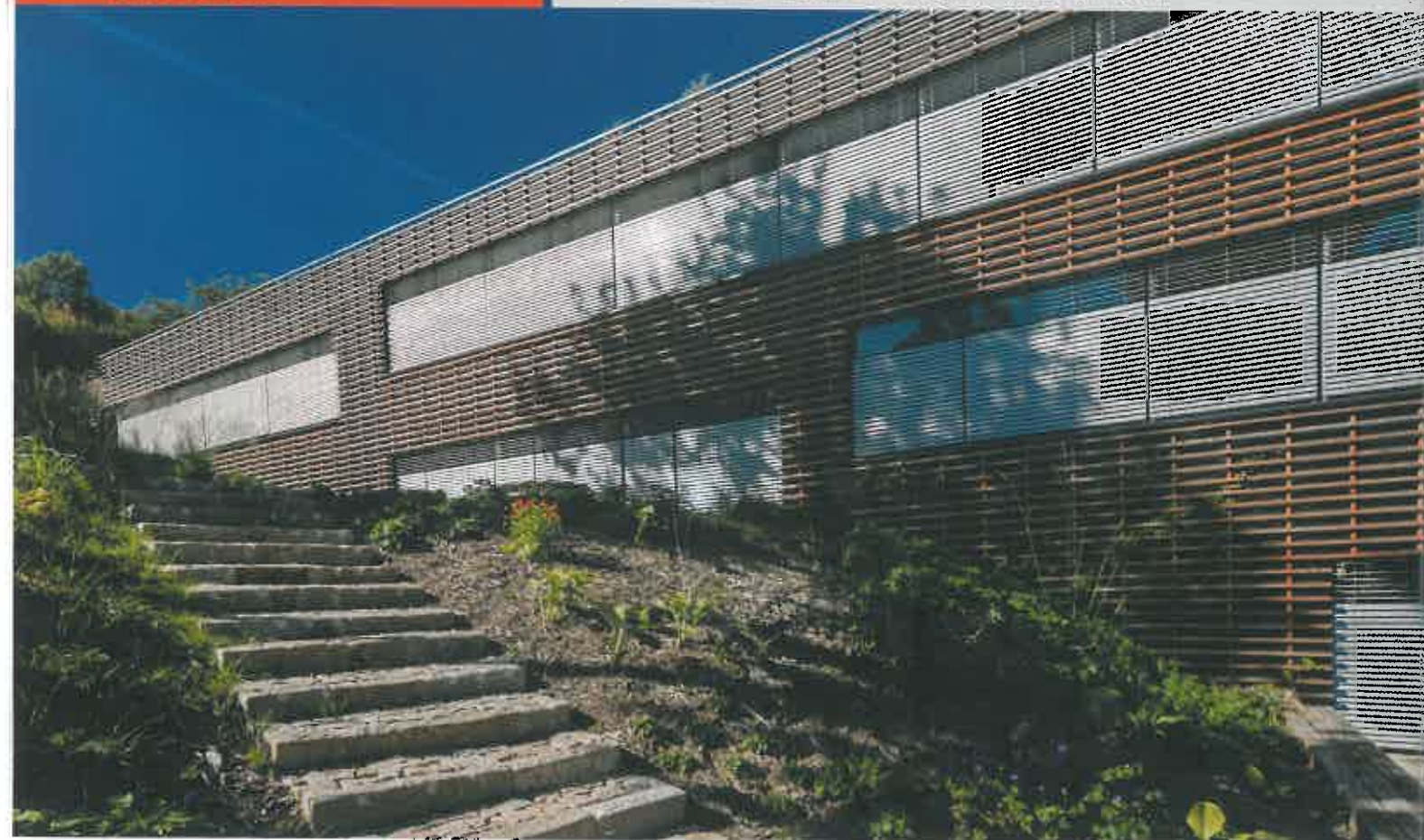
▲ Novostavba poradenského centra v Brně (foto: Tomáš Malý)
